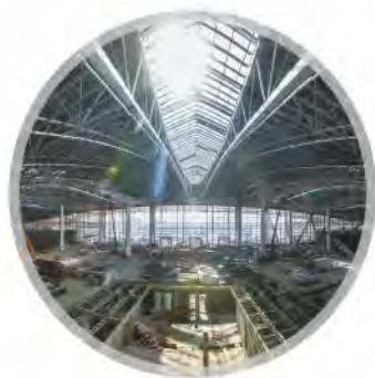
旅检A区15米层吊顶转换层施工 较计划提前10天完成
