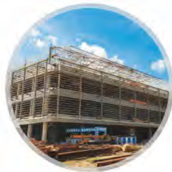
珠海口岸交通连廊幕墙 钢结构龙骨提前16天完成
