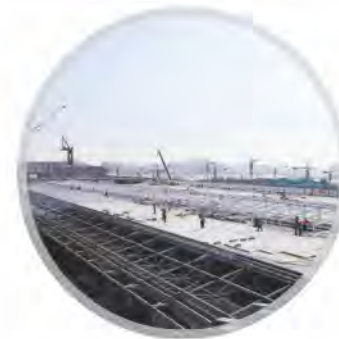
旅检B区屋面1.7万㎡ 压型钢板19天完成铺设
