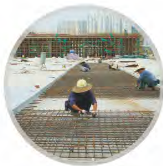
双台风过境72小时后 珠海口岸建设全面复工
